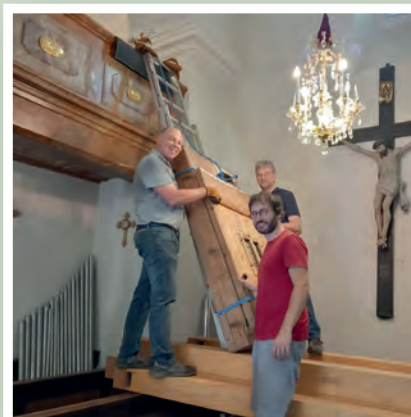
Abseilen der schweren Windlade, des „Herzstückes“ der Orgel
