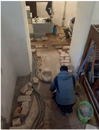
Die stiftlichen Maurer legen die vorbereitete Elektrik in den barocken Boden
