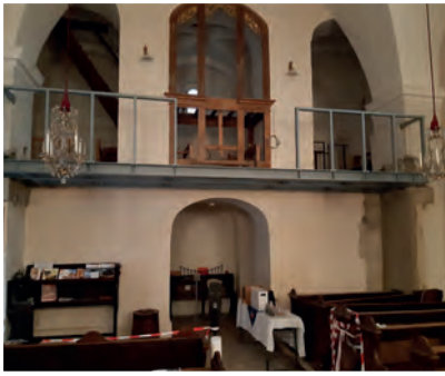
Die neue Stahlunterkonstruktion
