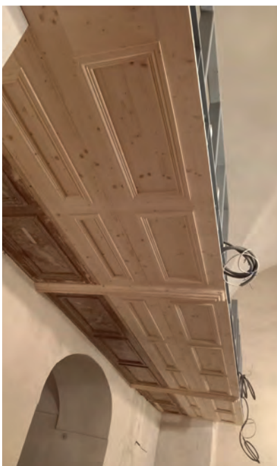
Die stiftlichen Maurer legen die vorbereitete Elektrik in den barocken Boden
